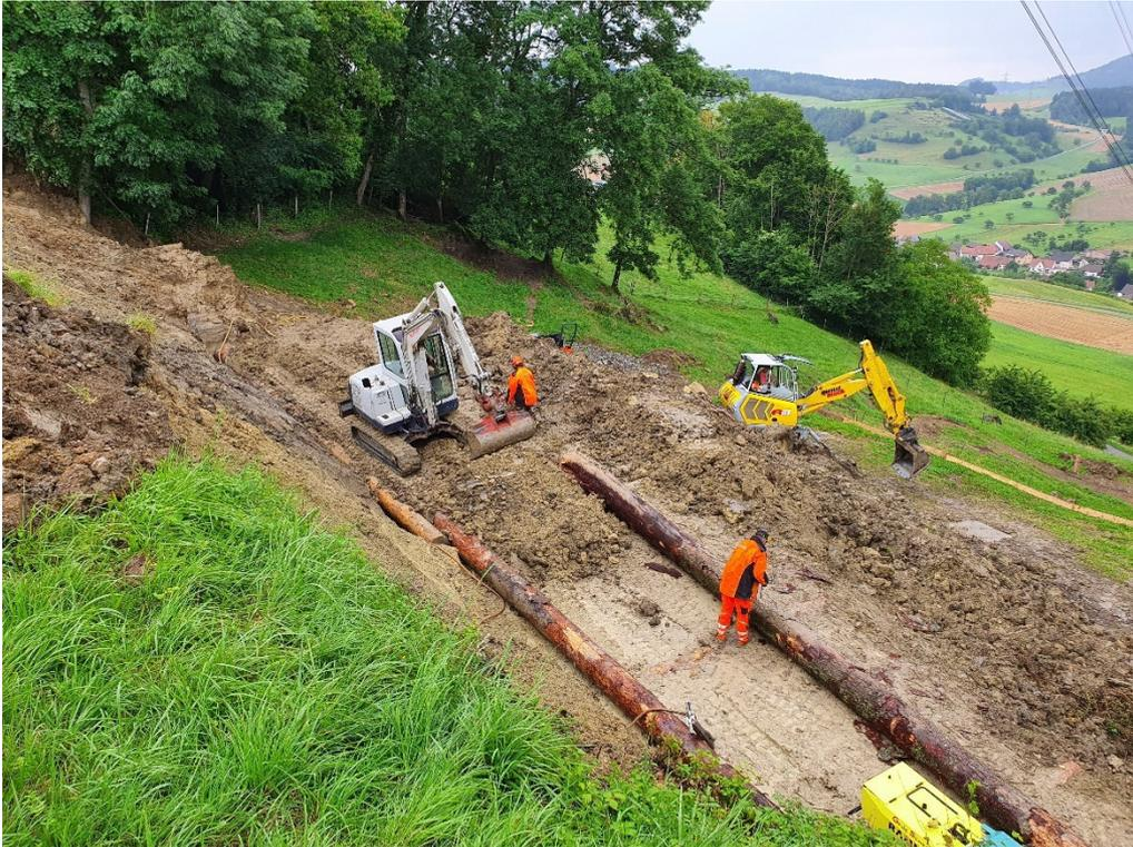
Abbildung 5 Hangsanierung Voregg mit einem Holzkasten
